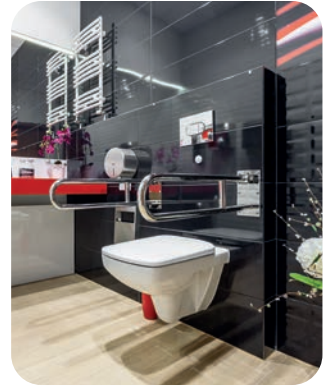
Es sind die kleinen Dinge im Leben, die das Leben leichter machen. Wie hier das niedrige und fast frei stehende Waschbecken und die Handläufe bei der Toilette. Foto: istock
